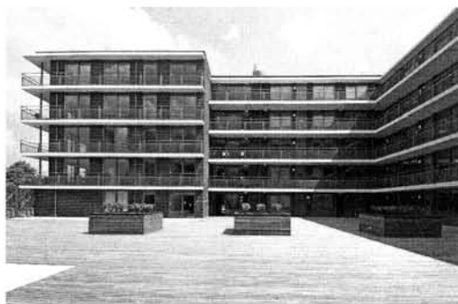
Herstructurerende woningbouw in de Pedagogebuurt.
