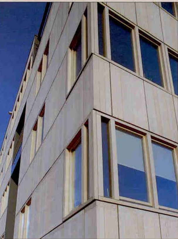
△ Gevelpanelen, opgebouwd uit western red cedar planken, en western red cedar kozijnen.
