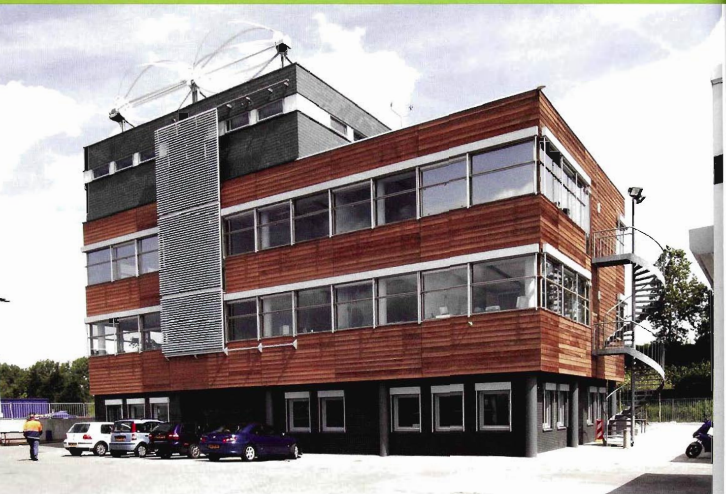
Kantoor met 'slagroomklopper' op het dak
